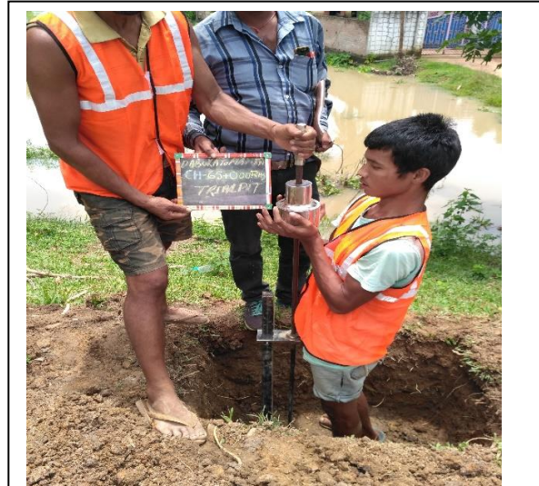
65+000 RHS OF NH-29
